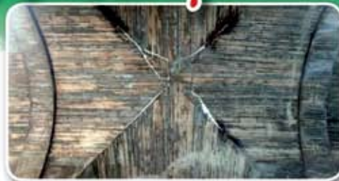
Так выглядит бетонный потолок в храме
